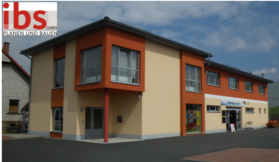
Bauplanungsbüro in Schalkau/ Thüringen
